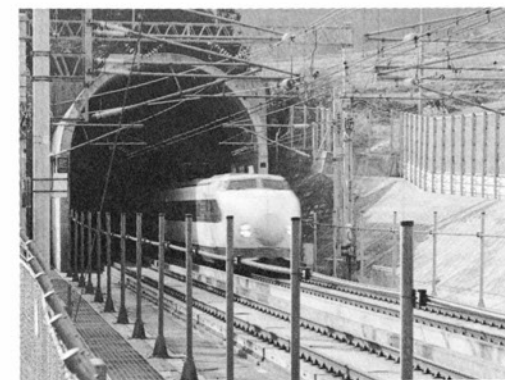
蔵王トンネル(東北新幹線)に利用
