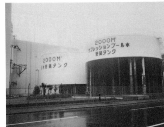
女川原子力(発)サプレッションプール水貯蔵タンク
