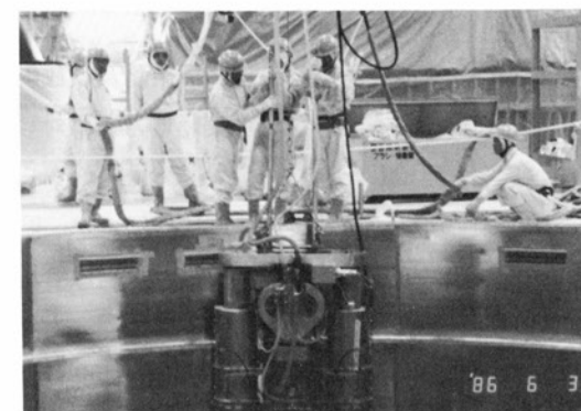
女川原子力(発)1号機定検工事
