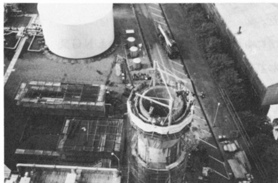
勿来火力(発)3号機解体撤去
