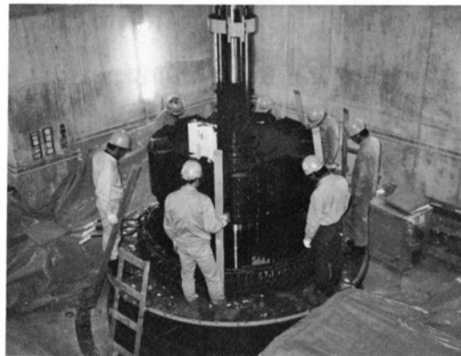
新草津(発)新設工事
