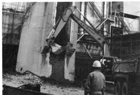
新潟火力(発)煙突撤去工事
