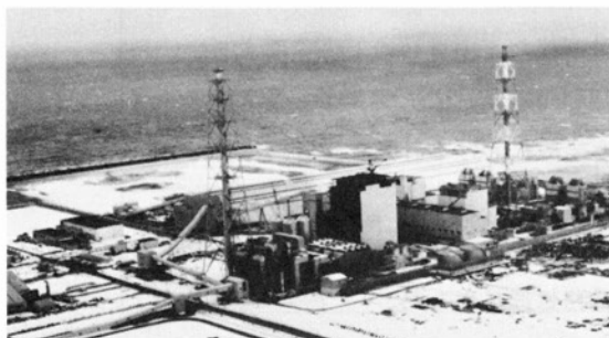
酒田共同火力(発)1号機石炭焚転換工事
