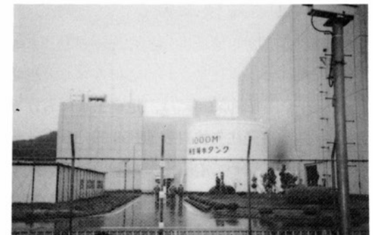
再生純水タンク
