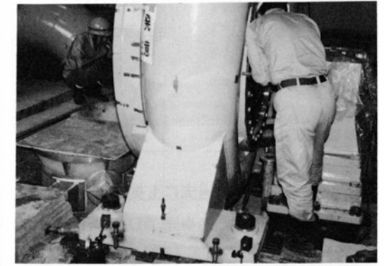
寒水沢(発)移設工事
