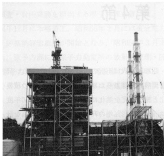
秋田火力(発)4号機据付工事
