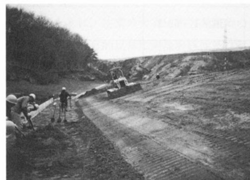
仙台火力(発)第2灰捨地整備工事
