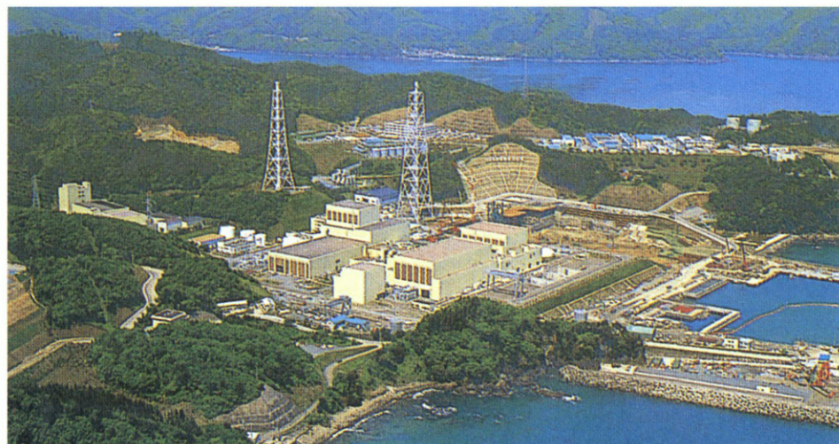
女川原子力発電所3号機は2002年1月の運転開始を目指して工が進んでいる。
