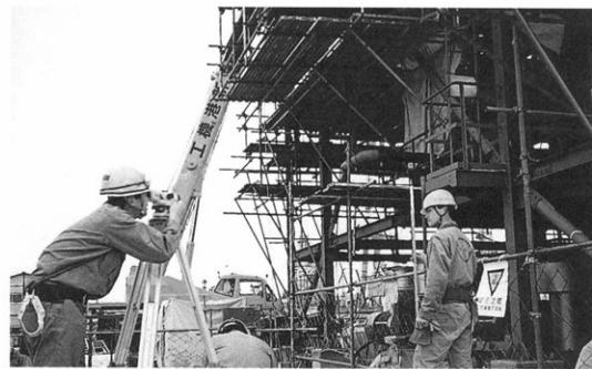
東北石油(株)仙台製油所#3排熱ボイラ据付工事
