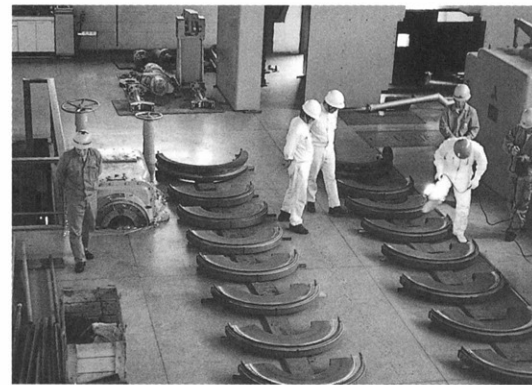
大昭和製紙(株)岩沼工場3号タービン定期点検工事 官庁検査
