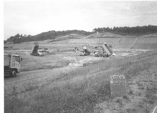
原町火力（発）石炭灰処分場
