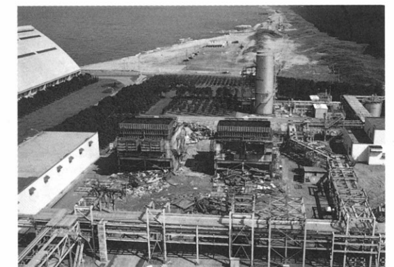
酒田共同火力発電（株）の石炭専焼転換工事
