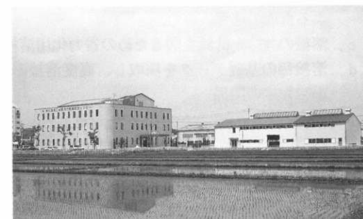
本館溶接棟全景
