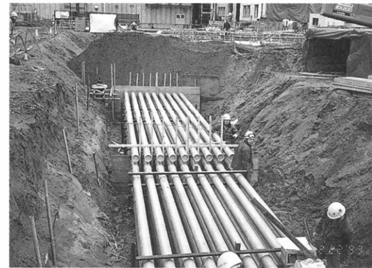
能代火力(発)建設工事先行工事 主管路埋設
