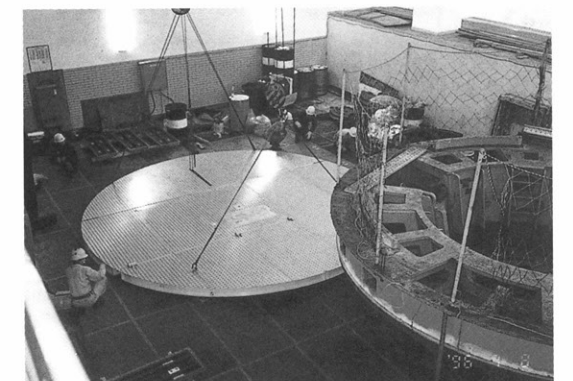
点検足場組立状況
