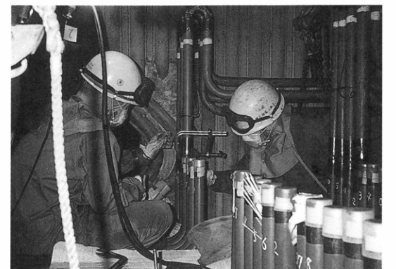
八戸火力(発)3号機節炭器取替工事配管開先合せ
