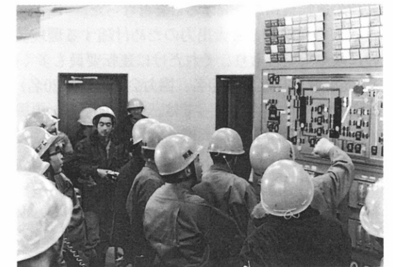
東北電力（株）初の排煙脱硫装置試運転（昭49.3.2） （八戸火力（発）石灰石膏法：昭49.4.1半量運開）
