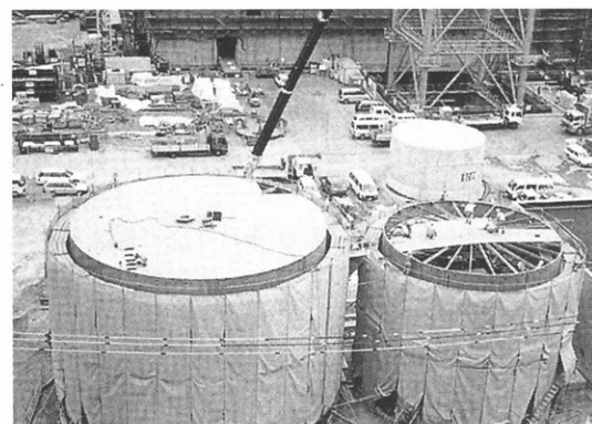
女川原子力発電所3号機建設工事
