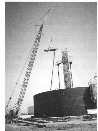
原町火力(発)重軽油貯蔵払出設備 9800KL重油タンク据付
