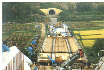
盛岡以北の東北新幹線工事も着実に進んでいる。
