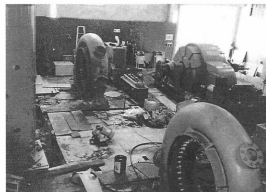
鶴沼川発電所リプレース前
