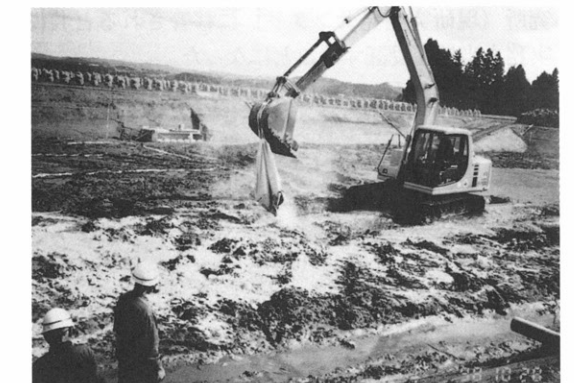
FA-MICSによる水田貯水池堆積底泥の中性土質改良工事(添加・攪拌状況)
