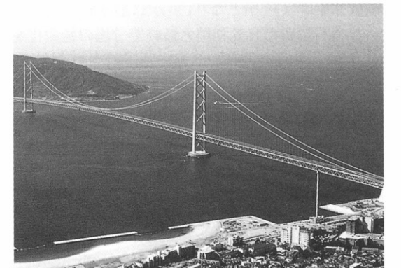
明石海峡大橋
