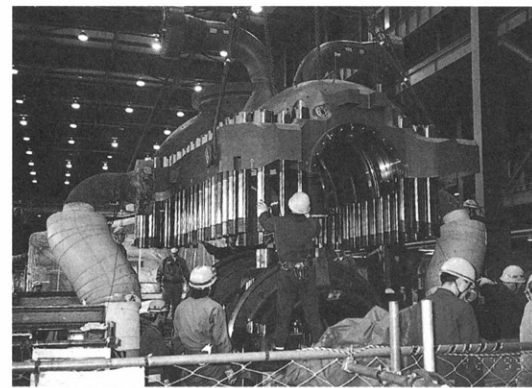
秋田火力(発)2号機高中圧車室取替工事 新製上半車室仮組み
