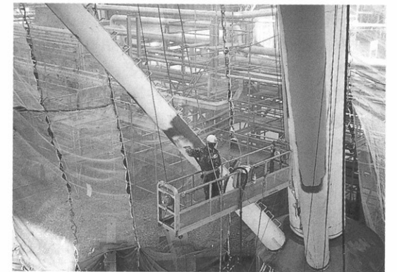
新仙台火力(発)集合煙突塗装工事
