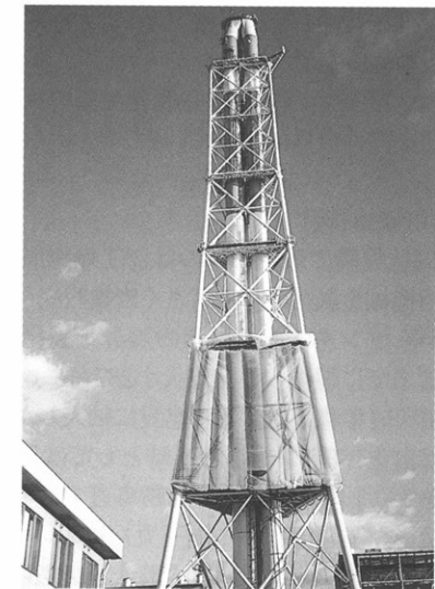
新仙台火力(発)集合煙突塗装工事
