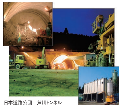
日本道路公団 芦川トンネル
