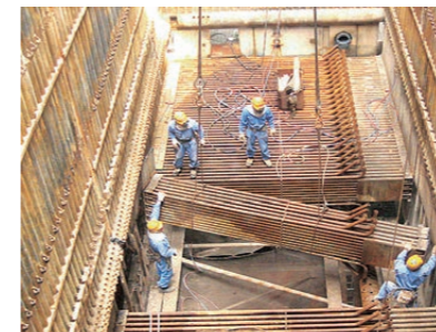
仙台火力(発)1号ボイラ節炭器撤去
