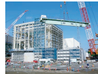
東通原子力(発)海水ポンプ室天井クレーン上架
