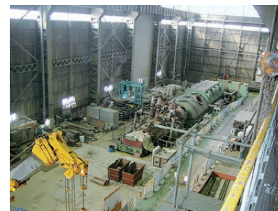
仙台火力(発)1号タービン撤去
