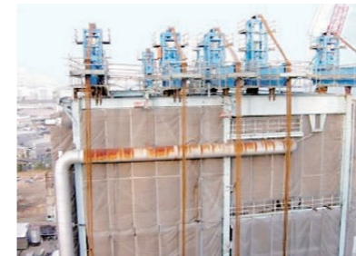
八戸火力(発)4号ボイラ撤去(油圧ジャッキ装置)
