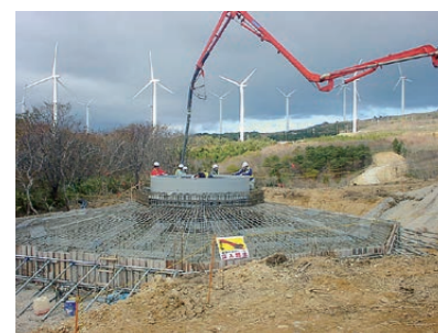
辰芳ウインドファーム風車基礎設置
