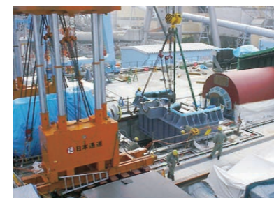
IGCC 低圧タービン外車室搬入
