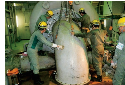
東北電力(株)蔵々発電所 水車分解(直営作業)
