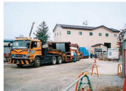
第二上野尻(発)建設工事組立部品搬入
