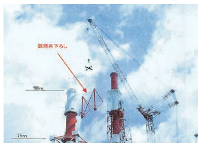
秋田火力(発)1号煙突撤去
