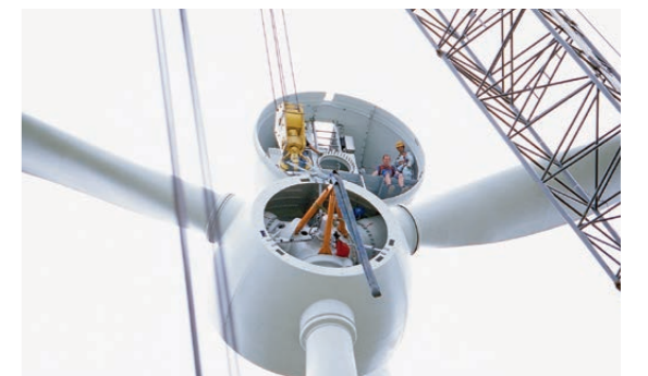
東北自然エネルギー開発㈱能代風力(発)風車据付工事
