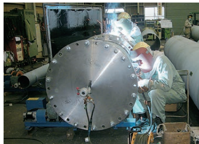
流量計短管溶接(半自動溶接)
