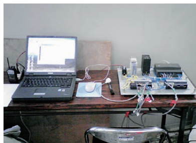
水車発電機振れ見自動測定装置
