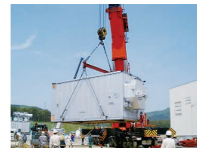
東通原子力(発)補助ボイラー(A)搬入
