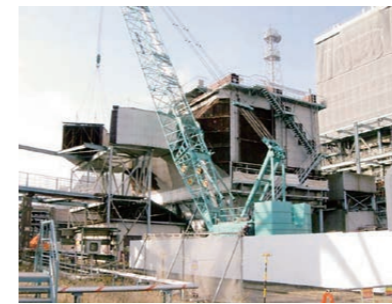
八戸火力(発)4号煙道撤去
