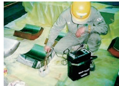
軸受UT検査
