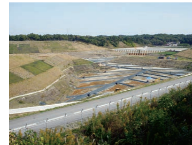
原町火力（発）石炭灰処分場
