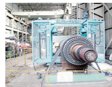
仙台火力(発)2号発電機ローター切断
