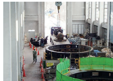
豊実(発)撤去状況
