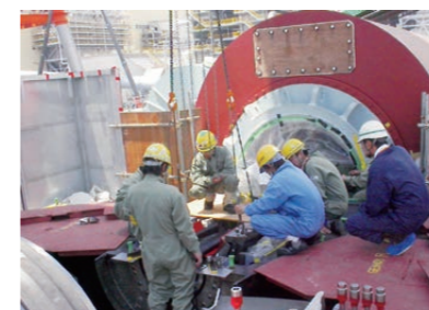
IGCC 蒸気タービン軸受取付け
