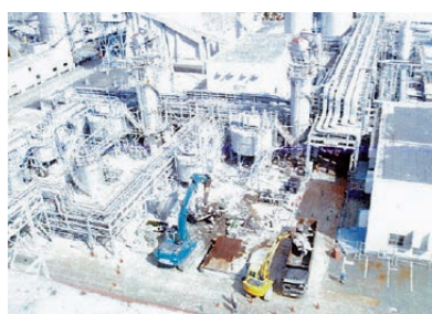
仙台火力(発)3号脱硝設備撤去
