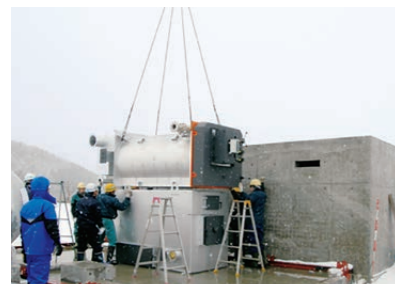
チップボイラ搬入据付
