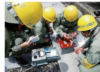
直営作業実施状況
