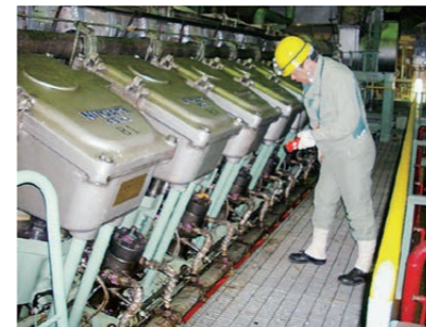
相川火力(発)現地巡視点検業務状況
