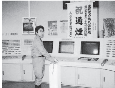
大規模新鋭石炭火力(発)集中管理型環境装置運転業務 (能代火力(発)2号機試運転)
