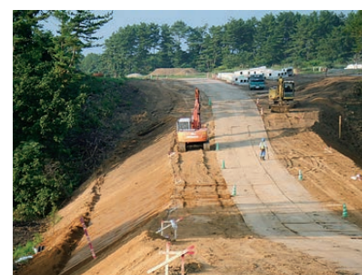
野辺地ウインドファーム道路工事
