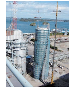
仙台火力(発)3号煙突撤去
