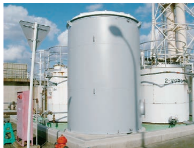
塩酸貯槽製作
