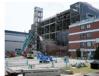
仙台火力(発)1,2号本館撤去
